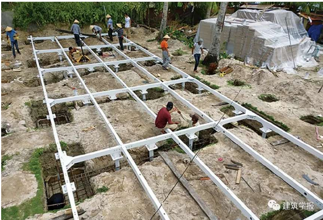
▲ 结构底框和预埋件的预拼装
