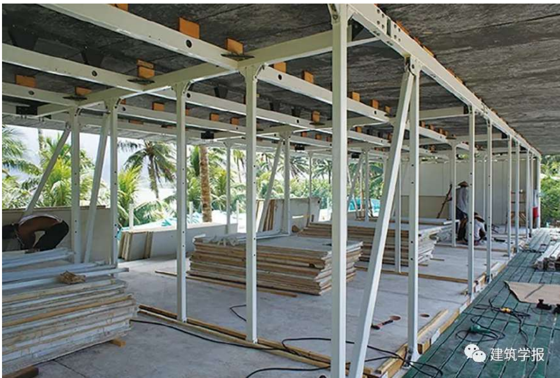
▲ 客房围护墙板的安装
